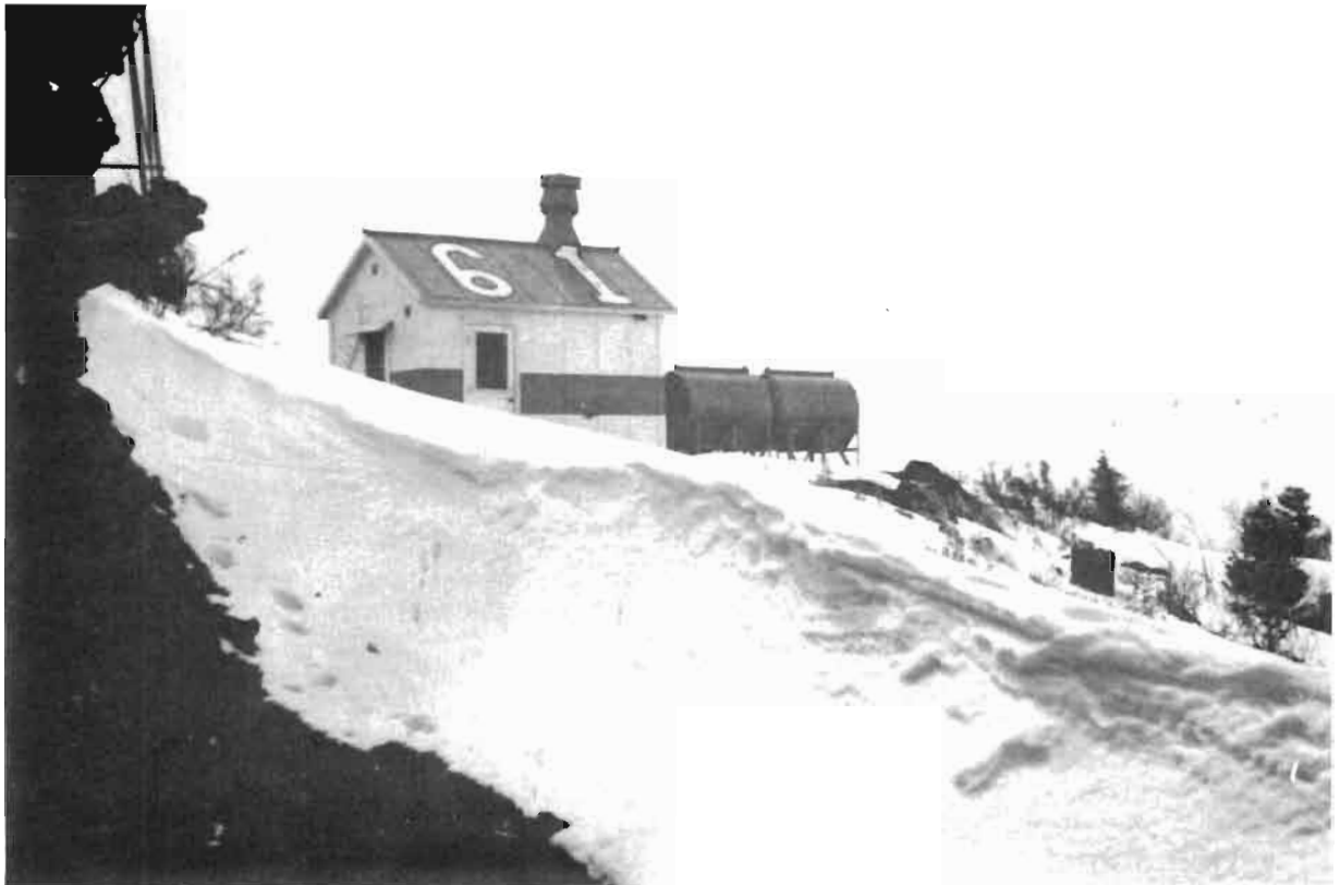
Oso Ridge, N. M., beacon and generator site
