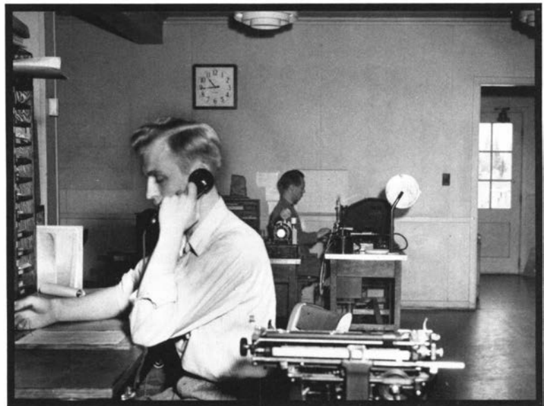
Fairbanks control room, CAA.
